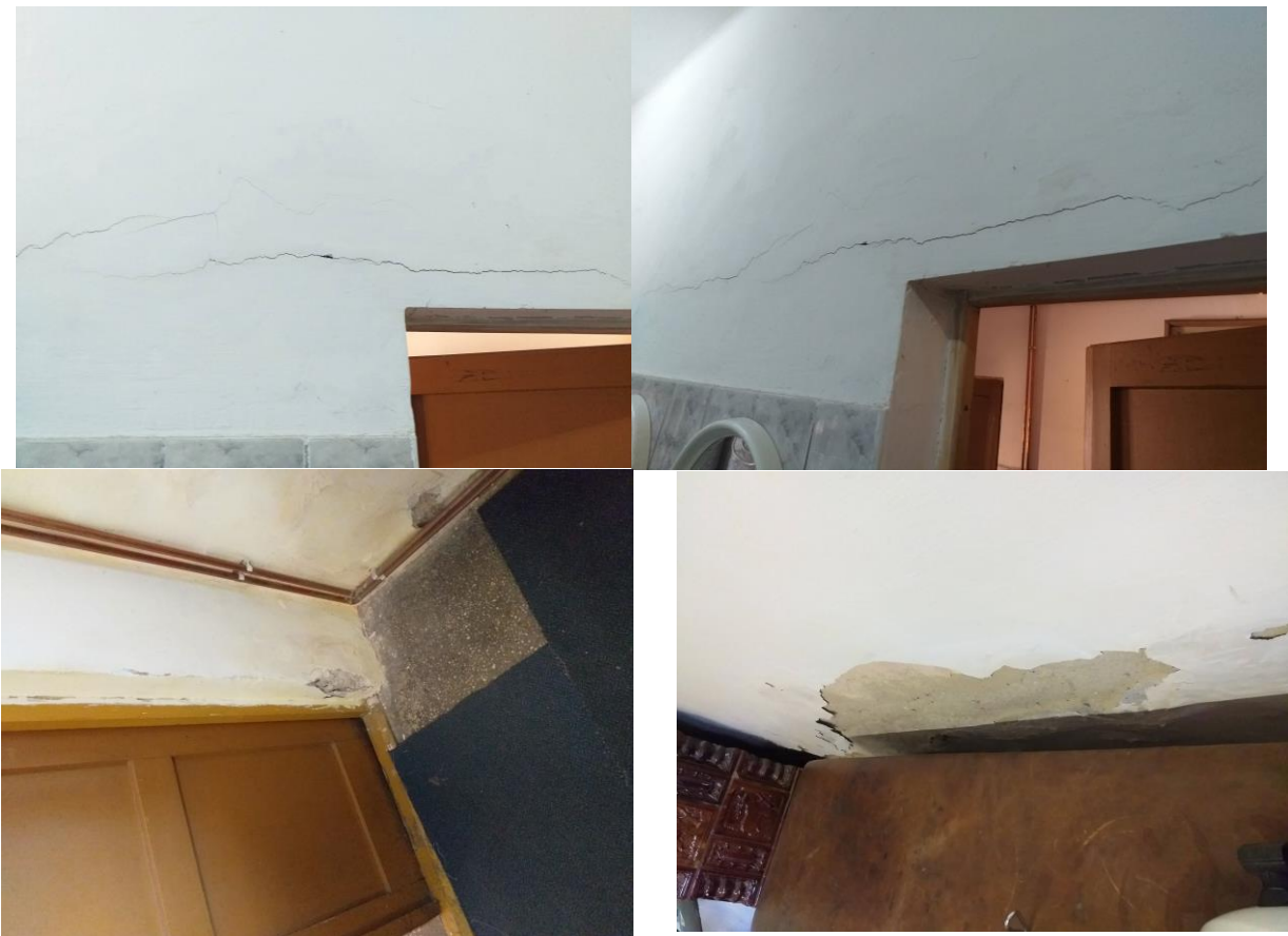
Figura 6. Starea actuală a clădirii
